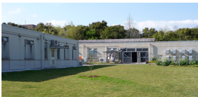
家畜環境制御実験棟
